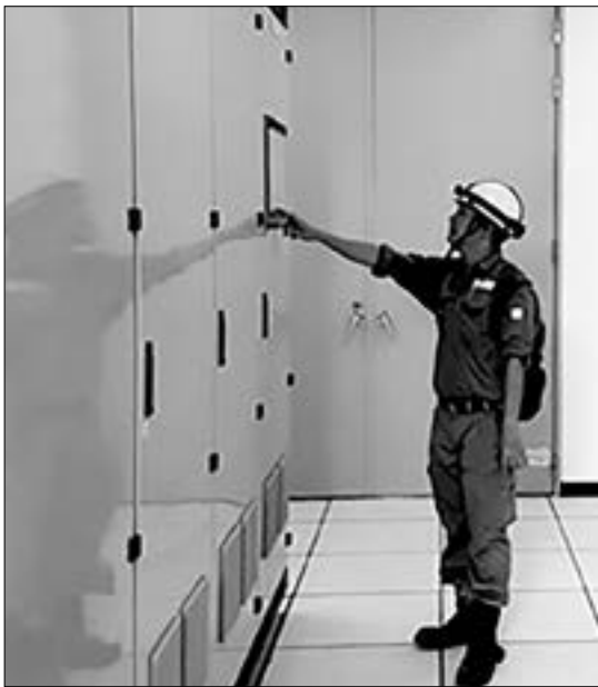
▲ Trạm xử lý nước thải chùa Cầu
